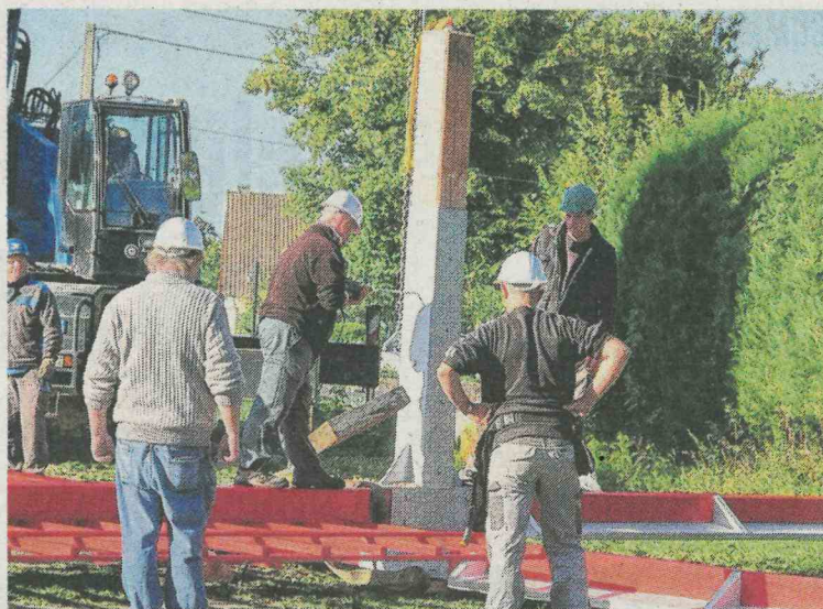
Avant de lever les ailes du sol, les artisans ont fixé la poutre en bois qui sert à relier les ailes à l'arbre principal, en s'encastant dans chacune des deux parties.
