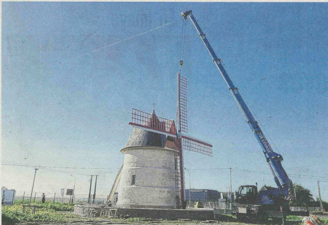
Pour monter les ailes d'une envergure de 17 m, il a fallu que la flèche de la grue s'élève à plus de 20 m au-dessus du sol.
