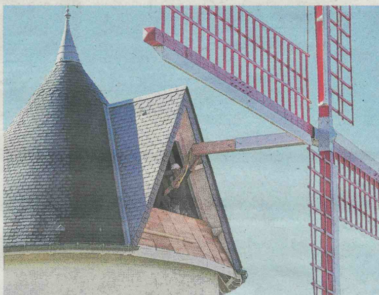
Une fois là-haut, il a fallu guider la structure à la main pour qu'elle rentre parfaitement dans son axe.
